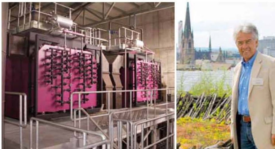
Im Bild: Ansicht zweier Biomasse-Rauchrohrkessel.
