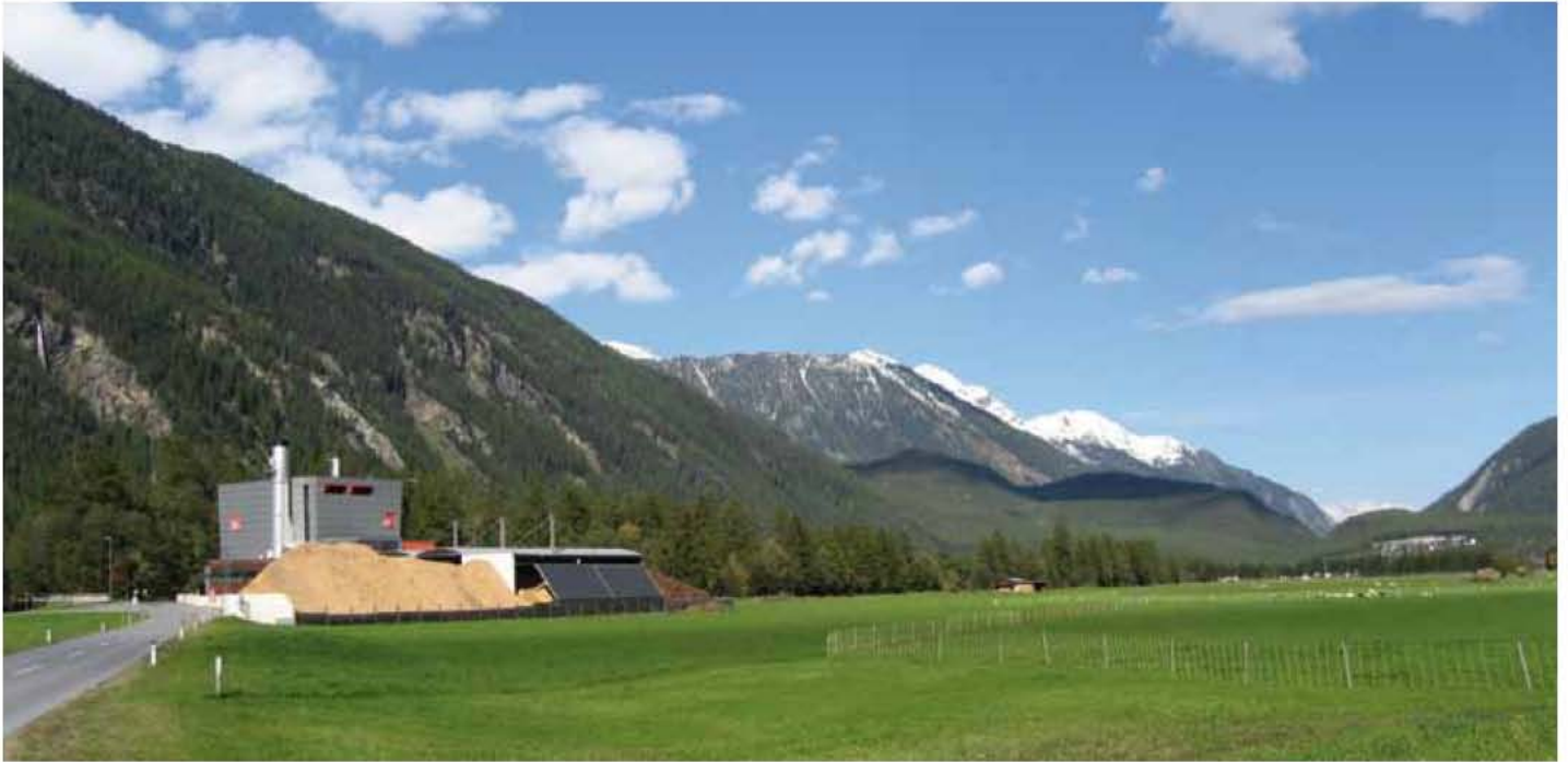
Das Biomasse-Heizkraftwerk Längenfeld im Oetzal versorgt 200 Haushalte mit einem 15 km langem Fernwärmenetz (Fotos: Polytechnik Biomass Energy).
